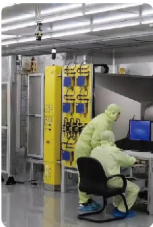
通风过滤检测台
